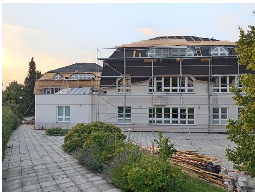
Oprava střech na budově Hornická 327 započala 1. 6., termín dokončení 31. 10. 2023
